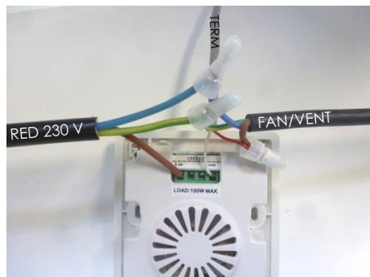
Figura nº12 - Conexiones a realizar en el potenciómetro.
